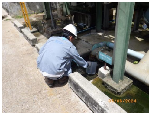
น้ำระบายทิ้งจากหอหล่อเย็นที่ระบายลงรางระบายน้ำของโรงงาน
